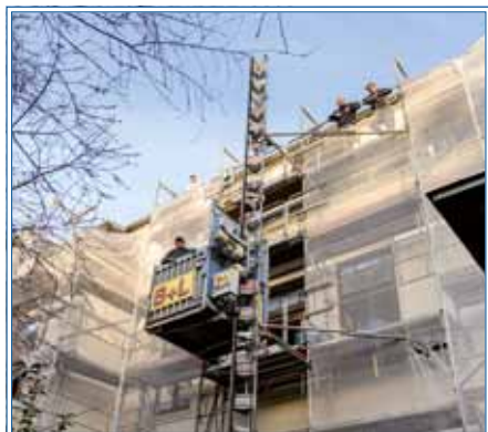
Gewerke an der Fassade
