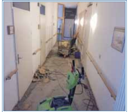
Erneuerung der Fußböden
