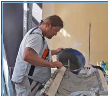
Der Stuckateur füllt Mörtel in die Form
