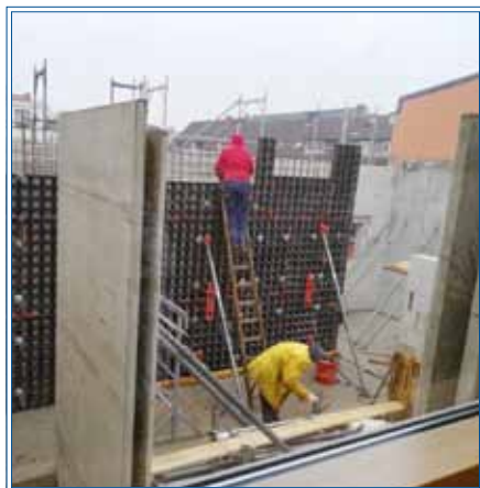
Bauarbeiten am Hospiz
